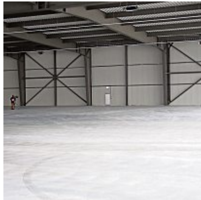
Der neue, 5500 Quadratmeter grosse Hangar C6 wurde soeben in Betrieb genommen. an
