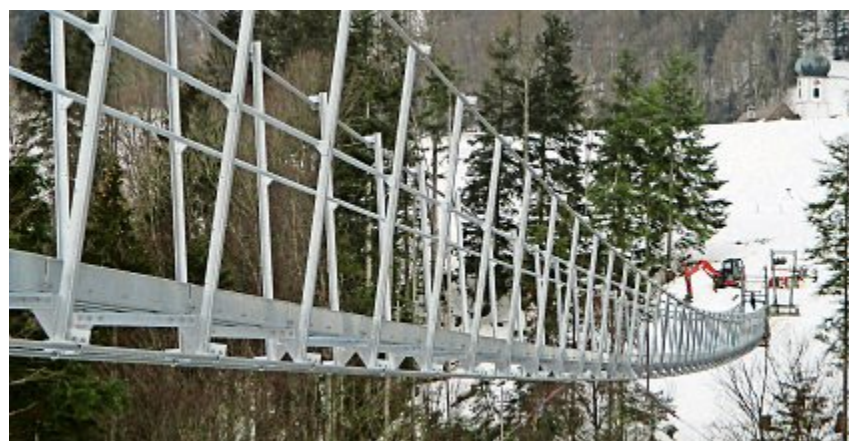
Die neue Hängebrücke soll ab diesem Frühling Grub AR und Grub SG verbinden. z.Vg
